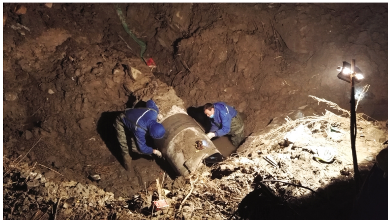
1月4日上午,利海化工公司接到用水客户报告原水水压下降。该公司立即组织员工冒雨沿途查找漏点,5日下午发现漏点后,员工放弃周末休息,不惧严寒在工作坑内加紧施工,终于在6日晚21时抢修结束恢复供水,保障了客户的正常生产。(陈靓)
